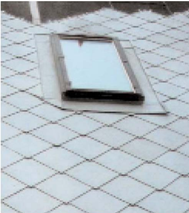
Okno mansardowe w pokryciu dachowym typu „rybia łuska”
