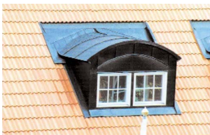
Obramowanie okna mansardowego zintegrowane z płytkami pokrycia
